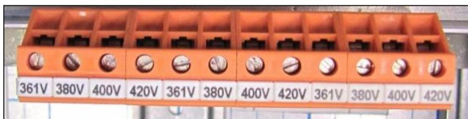
Рис. 5-12 Дополнительные входы для другого напряжения
