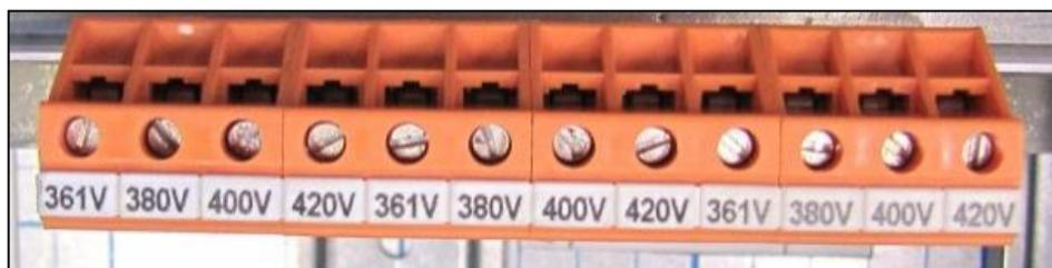
Imag. 5-12 Entradas adicionales para otras tensiones
