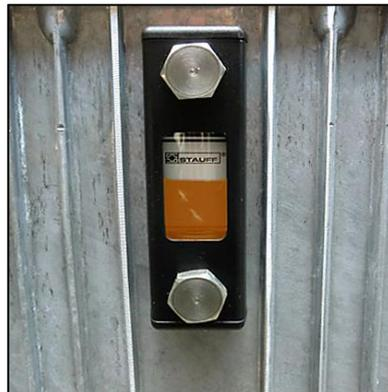
Abb. 5-1 Optimaler Öl-Füllstand
